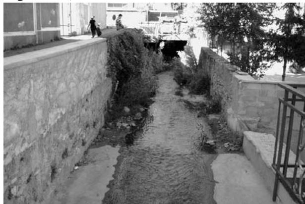
*Fotografia 16 - Cunettone visto da valle (scheda censimento opere idrauliche n° DAMICA002, allegato 2). L'argine sinistro è più basso del destro di circa 0.80 m.*
