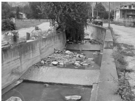
*Fotografia 11 - Soglie e muri di contenimento tra la SS n°25 e la ferrovia (schede censimento opere idrauliche n° DAMIDS023 e DAMIBR023, allegato 2).*
