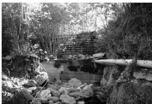
Fotografia 21 - Briglie selettive viste da valle (schede censimento opere idrauliche n° DAMIBR002 (sinistra) e n° DAMIBR018 (destra), allegato 2).
