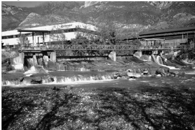
Fotografia 2 - Opera trasversale di derivazione (scheda censimento opere idrauliche n° STRISO001, allegato 2). L'opera si mostra parzialmente danneggiata nella parte destra.
