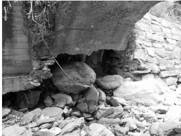
*Fotografia 9 - Spalla sinistra del ponte ad arco con evidenti segni di sottoscalzamento.*
