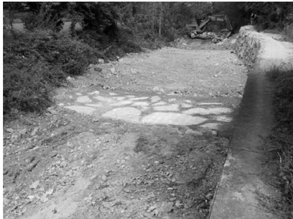
*Fotografia 10 - Briglia (scheda censimento opere idrauliche n° DAMIBR020, allegato 2). La briglia fa parte di una serie di 5, di recente costruzione.*
