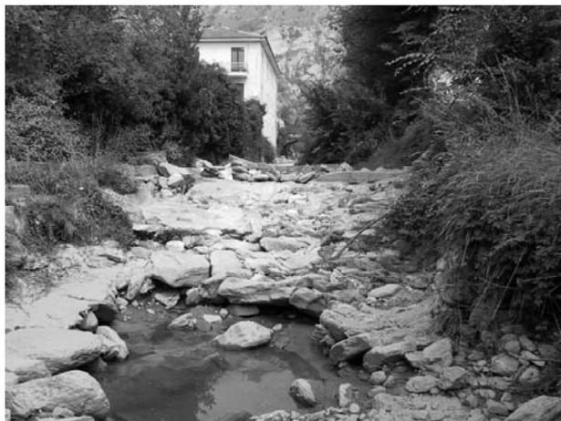
*Fotografia 8 - Briglia a valle del ponte di Foresto (scheda censimento opere idrauliche n° DAMIBR019, allegato 2). La platea mostra evidenti segni di sottoscalzamento*
