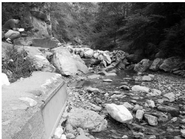
*Fotografia 7 - Opera di derivazione (scheda censimento opere idrauliche n° DAMIBR001, allegato 2) parzialmente ripristinata con blocchi e sacchi di sabbia in seguito dell'evento alluvionale dell'ottobre 2000.*
